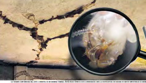
LA TERMITA SURTIDA DEL COTI Y DEL COTI EN EL BOSQUE DE PALMAS DE LA LAGUNA. EN ESTOS TERMITOS LOS COLONIZADORES CONSTRUEN SU RED DE TUNELAJES Y CÁMARA DE ALMACÉN. FUENTE: ANECPLA
